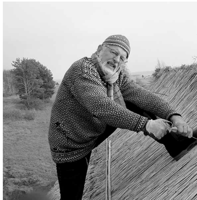
Loo autor oma Kase talu kuuri roogkatuse harja lõpetamas. See on endises kihnasemal seovad harja horisontaalsed malgad, mis hoiavad meretuulte vallas katuse
